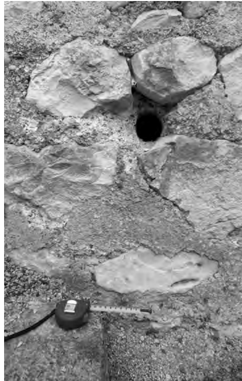
Илл. 14. Храм Св. Феодора в Анакопии. Отверстие от строительных лесов в алтарной части
