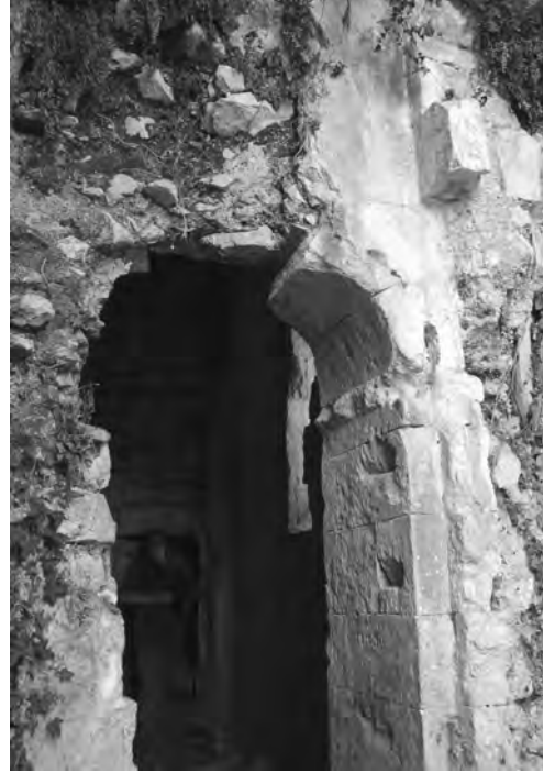
Илл. 56. Храм Св. Феодора в Анакопии. Арочный проход в северное помещение субструкций. Вид с юга
