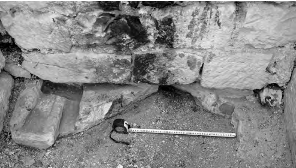
Илл. 16. Храм Св. Феодора в Анакопии. Блоки-подпятники в заложеном дверном проеме
