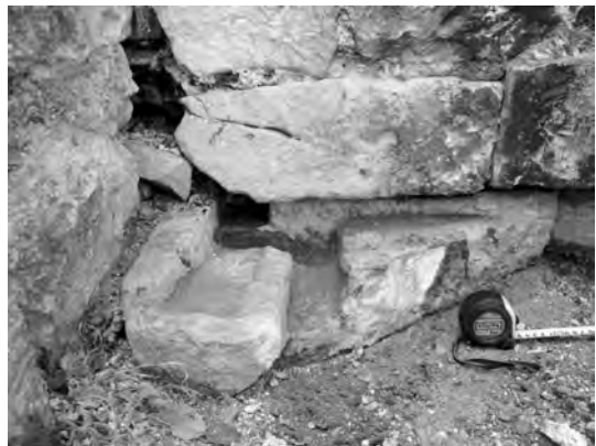
Илл. 17. Храм Св. Феодора в Анакопии. Левый блок-подпятник заложеного дверного проема в южной стене
