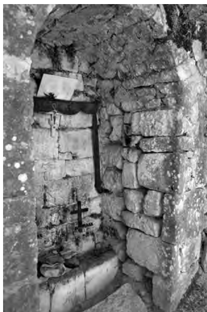
Илл. 37. Храм Св. Феодора в Анакопии. Западная ниша в южной стене. Правый откос
