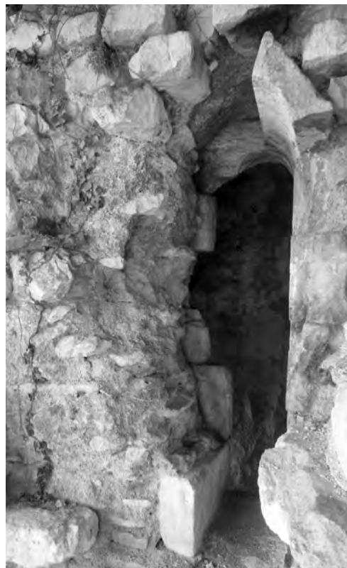
Илл. 58. Храм Св. Феодора в Анакопии. Оконный проем в северном помещении субструкций. Вид с фасада
