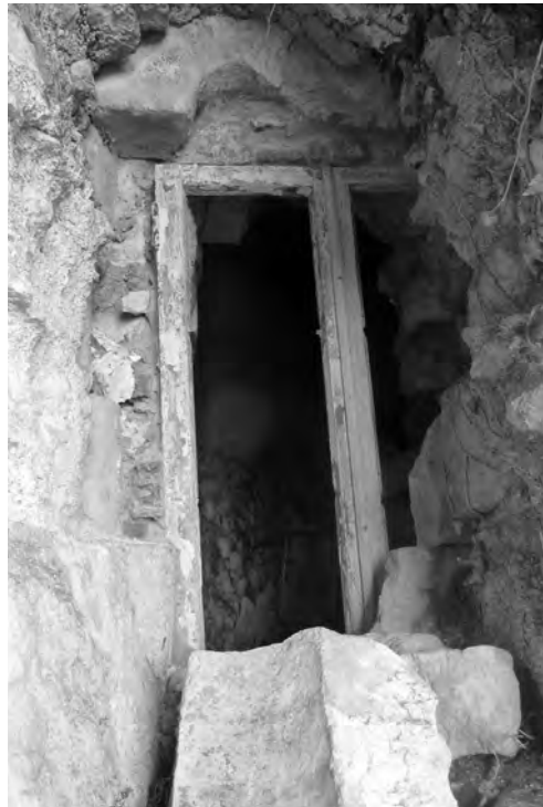
Илл. 59. Храм Св. Феодора в Анакопии. Оконный проем в восточном помещении субструкций. Вид с фасада
