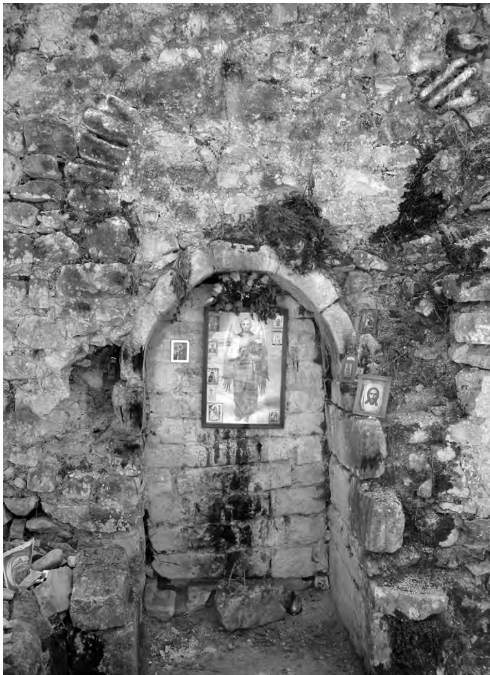
Илл. 15. Храм Св. Феодора в Анакопии. Заложенный дверной проем в южной стене
