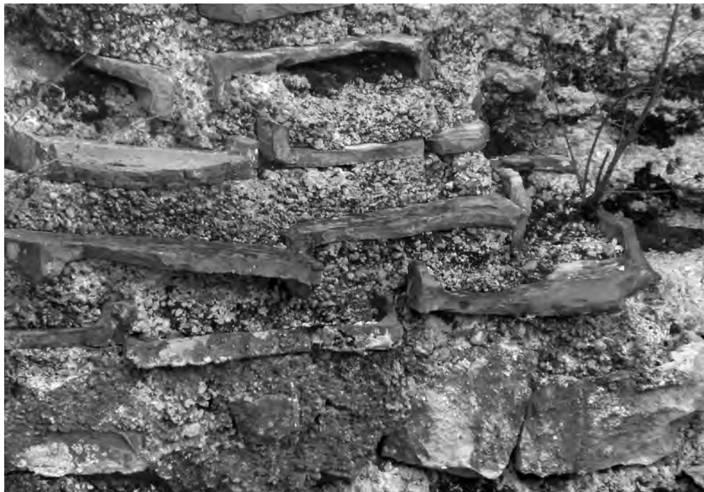
Илл. 11. Храм Св. Феодора в Анакопии. Внешняя стена апсиды. Массив черепицы в кладке первого этапа
